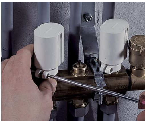
Rozdělovač s termostatickým ventilem
