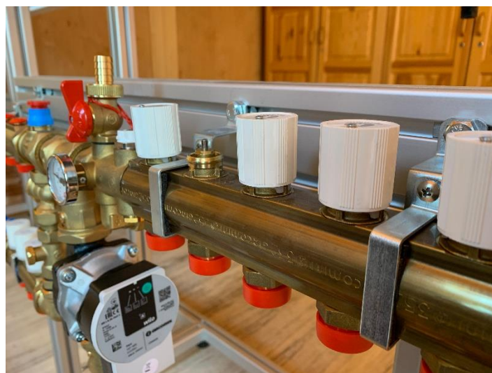
4 Páčením šroubováku a tahem směrem vzhůru hlavu demontujeme.
