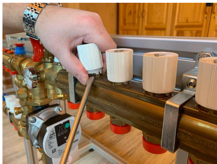
4 Páčením šroubováku a tahem směrem vzhůru hlavu demontujeme.
